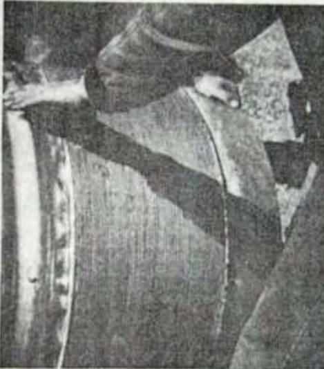
Treinta centímetros de filtro de 762 mm (30'') de diámetro se acoplan a una tubería durante la demostración de la empresa Cloverleaf Drilling.
