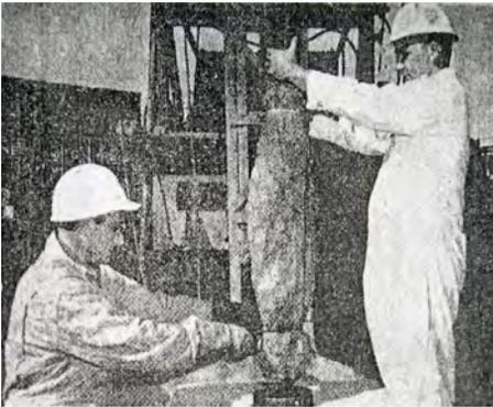
Fig. 2. Aquí se muestran las tiras o bandas de arpillera atadas con alambre al extremo inferior del tubo extractor. Las bandas se han llevado hacia arriba y atado provisoriamente al tubo.
