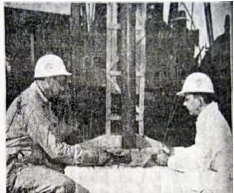
Fig. 3. Se desata la parte superior de la arpillera y se distribuyen las tiras uniformemente alrededor del revestimiento del pozo.
